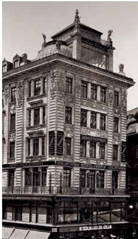
En haut: Le siège de la compagnie d'assurances «Der Anker» à Vienne (1 er arr., à l'angle Graben 10 / Spiegelgasse 2), édifié en 1895 par Otto
